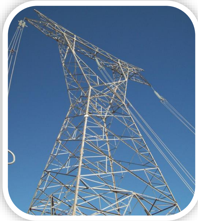
RR-PT06. Instalación punto de corriente de alta tension
