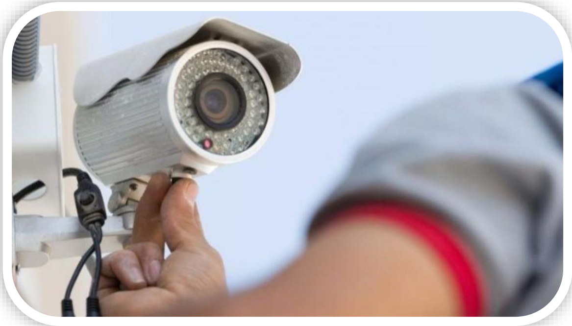
RR-MTT01. Mantenimiento de punto de cámara de seguridad
