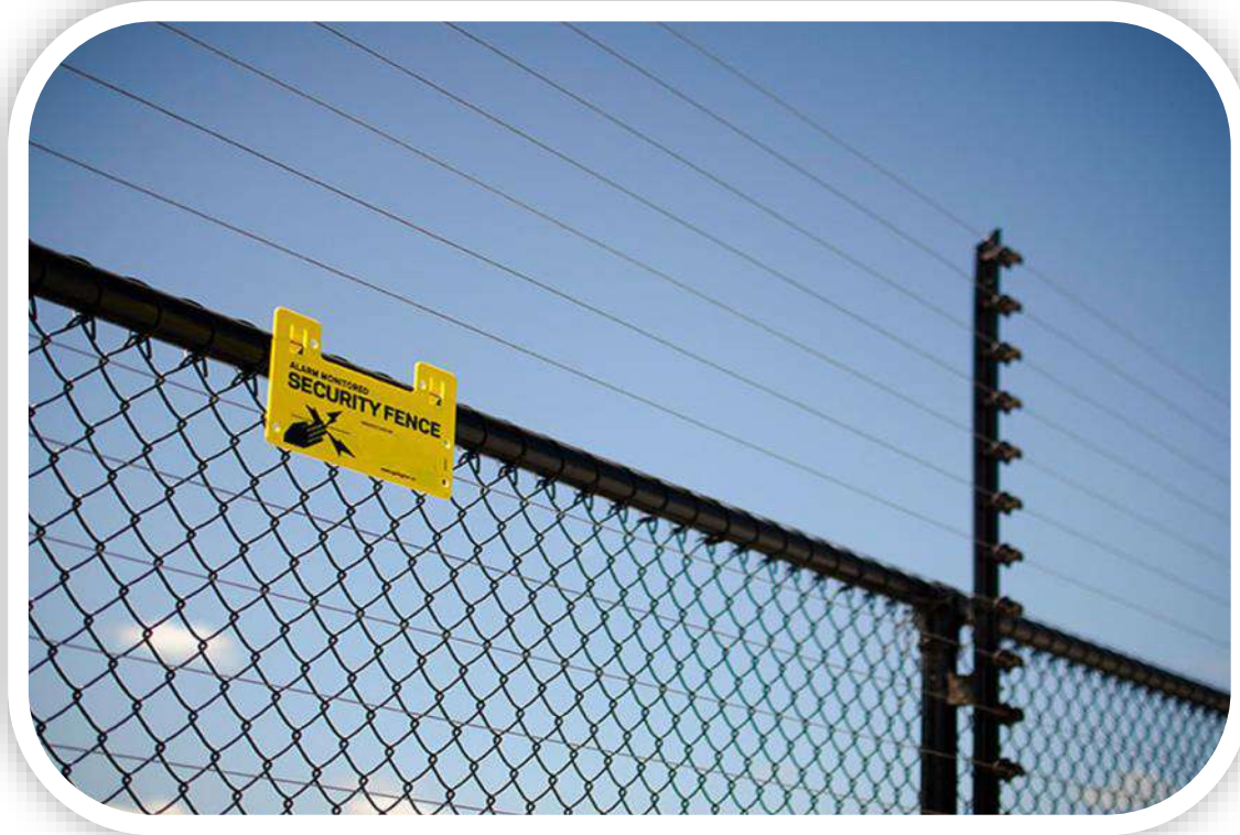
RR-CERC02. Mantenimiento de cerco electrico por metro
